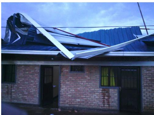
En mars 2017 une forte pluie a détruit la toiture d'un bâtiment nouvellement construit. Ce bâtiment abritait la cuisine des enseignants et l'infirmerie des élèves.
